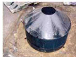
Plaats het herbruikbaar stalen inbouwformeel op de adapterring.
