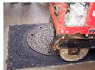
Definitief inwalsen van deksel in de asfaltlaag.
