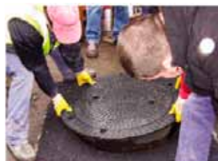
Wegnemen inbouwformeel en plaatsen deksel.
