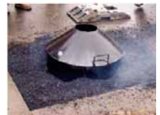
Inbouwformeel rondom aanvullen met asfalt.
