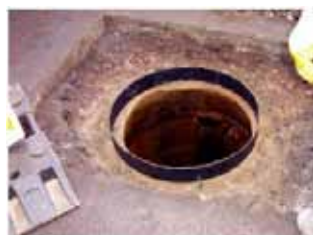
Plaats de adapterring op de bovenbouw op een hoogte tussen de 170 en 230 mm.
