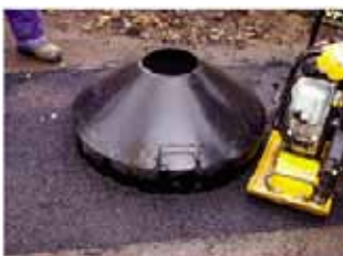
Compacteren van de asfaltlaag met trilplaat.
