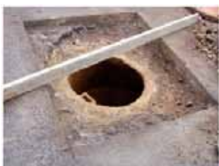
Verwijderen van het oude deksel en controle van de bovenbouw v/d schacht.
